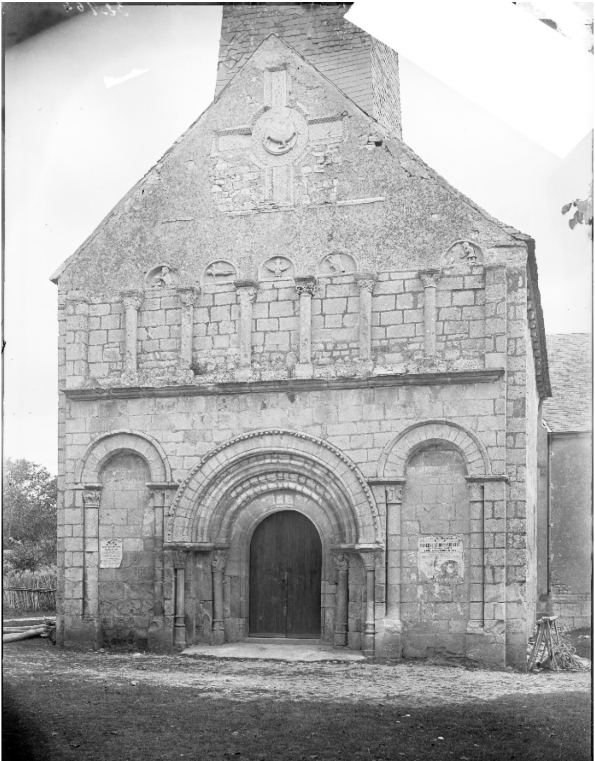
109. ↑ Peu avant 1900, peu après la précédente Camille Enlart source MPP mh032964 (l'affiche à droite indique « RESERVE ET DISPONIBILITE De l'Armée Active, APPEL A L'AUTOMNE DE 1895 ») Peu de différences avec la précédentes (perte d'un fragment de mortier au coin supérieur droit du bras droit de la croix, agrandissement du trou dans la maçonnerie à droit de cette croix, végétation nouvelle au pied de la seconde des six colonnes hautes). Cette photo renseigne assez bien sur l'état des colonnes hautes et de leurs chapiteaux (comparaison avec l'état actuel figure 154 page 45).
