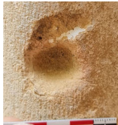
90. ← Trou creusé par la dégradation de pyrite en haut à gauche dans la voussure du portail. 20220916_104145
