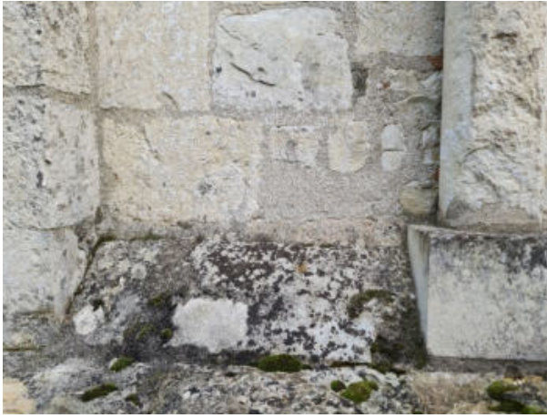
41. ← Talus entre le pilastre nord et la première des colonnes hautes 20220915_163658
