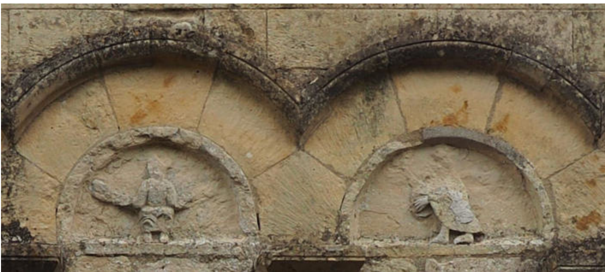
140. ↑ 16/9/2022, agrandissement de la figure 111 page 35. La modification du profil du bandeau des arcades par Jacquet en 1961 semble avoir mieux protégé les parties au-dessous, car le layage de ravalement 1961 est peu abîmé si on compare l'évolution de la figure 139 à celle-ci à l'évolution des figures 138 à 139. En dépit du manque de photos vers 1960, on peut supposer que la plus grande part des dommages aux reliefs est survenue avant 1961, même si ces reliefs continuent de s'abîmer.
