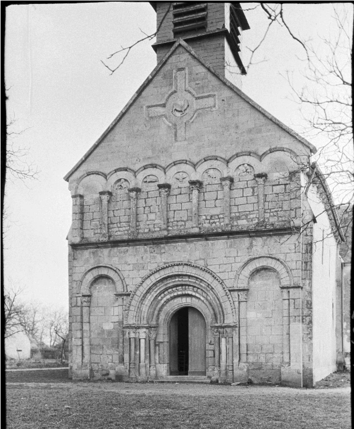
110. ↑1912, Lucien Roy, façade source MPP 10I06352. le pignon est en pierre de taille neuve, les vestiges dans l'ancien pignon ont disparu, le mortier au ciment autour de la croix est très clair mais des lichens ont eu le temps de se développer sur le parement neuf, le relief droit a été rapproché des autres, les bords extérieurs du mur de façade ont été éliminés en haut pour les transformer en contreforts surmontés d'une console qui soutient le bas du couverture du rampant en grandes dalles de pierre, les pierres abîmées de la corniche ont été remplacées mais les deux blocs à droite qui étaient les seuls encore en bon état figure 109 sont ici les deux seuls un peu abîmés. Deux colonnettes et bases neuves occupent le milieu des ébrasements, le chapiteau extérieur de l'ébrasement gauche a pris place au centre de l'ébrasement droit, un chapiteau neuf l'a remplacé, un autre chapiteau neuf a pris place au milieu de l'ébrasement gauche, des pierres de parement ont été remplacées en bas à gauche du portail et en bas à droite de la façade, un rejointoiement sombre est visible en bas du portail, la pente devant le seuil a été éliminée, les recouvrements sombres en bas à gauche de la façade ont été éliminés.
