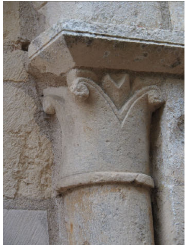
166.↑ Chapiteau droit de la baie aveugle gauche P9164953
