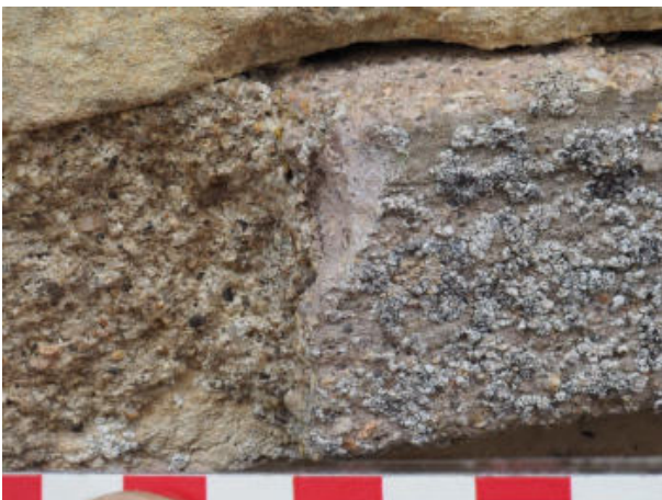
49. ↑ Haut du cadre du quatrième relief : à droite sur la photo, mortier de sable et ciment gris-rosâtre avec cassure fraîche. Comme le ciment figure 47 ce mortier semble dater de la restauration vers 1900 (figures 109 page 33, figure 110 page 34 ) P9134548
