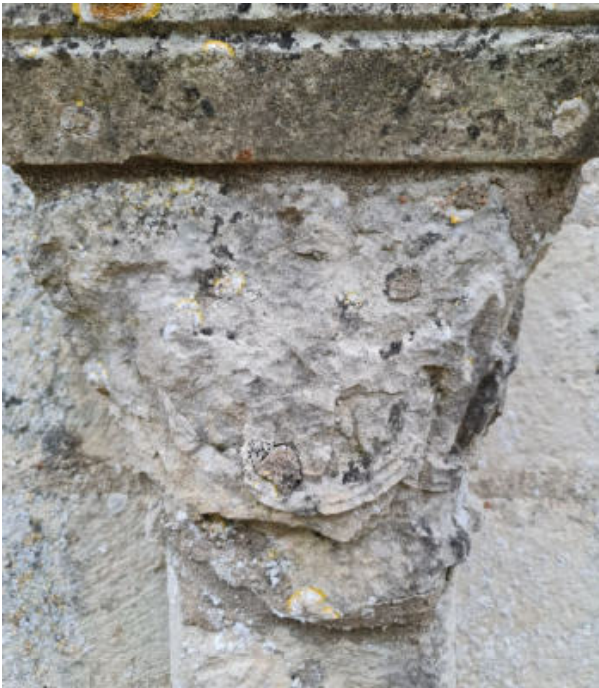
69. ← 2 ème chapiteau, on distingue les bouchages de mortier sur trois trous de goujons. 20220915_100555
