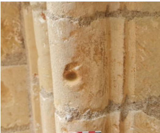
88. ↑ Détail des fissures multiples qui tendent à séparer les parties en saillie des parties plus massives du 4 ème chapiteau. 20220914_165301
