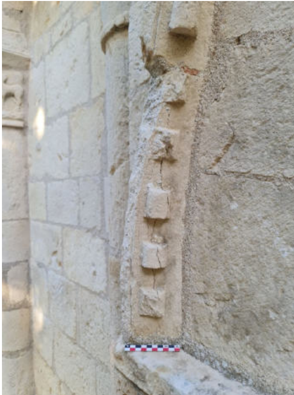
82. ↑ 1 er claveau d'archivolte à gauche : fissures et désagrégation 20220915_181502
