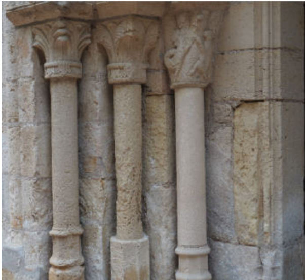
76. ↑ Alvéolisation de la pierre de l'ébrasement gauche du portail à hauteur des colonnes. P9164957 recadrée
