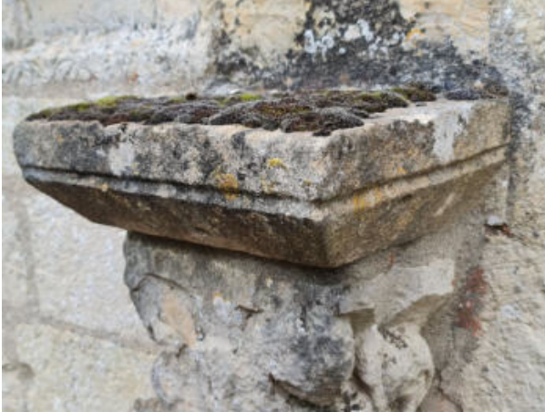
22. ← Tailloir du 3 ème chapiteau des colonnes hautes. Le profil de ce tailloir diffère un peu de celui des autres, et sa pierre plus grenue est plus propice aux mousses (visible figure 174 page 59) 20220914_175234
