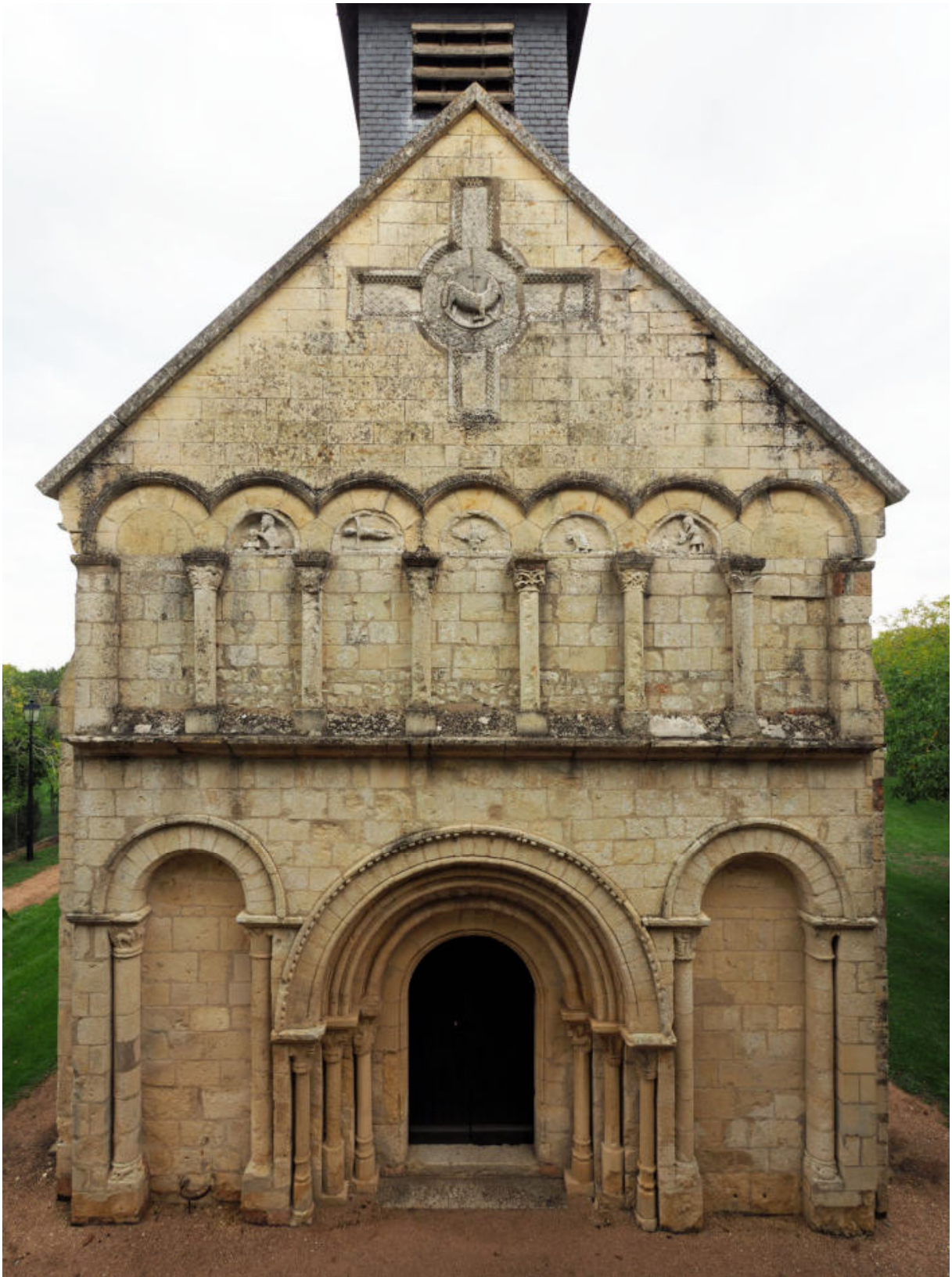
111. ↑ 16/9/2022. Les colonnettes intérieures ont été remplacées, le prolongement du tailloir du chapiteau gauche de la baie aveugle gauche a été remplacé, les autres remplacements sont plus discrets (parties d'archivoltes au-dessus des reliefs, blocs dans le bord gauche du mur de façade). Les dommages dus aux sels ont nettement évolué sur les parties inférieures, en particulier sur les parties remplacées vers 1900. P9164945 (redressée)
