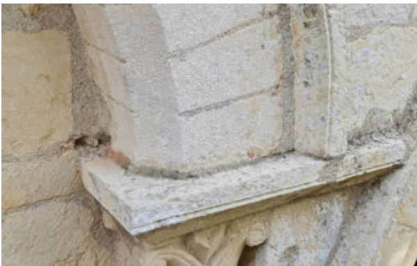
37. ↑ Mortier de tuileau sur le tailloir à droite dans la baie aveugle gauche 20220915_173829
