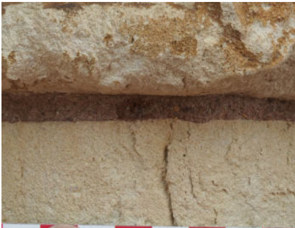
44. ↑ Mortier de pose du 2 ème chapiteau à droite, chapiteau d'origine posé là vers 1900 P9164902
