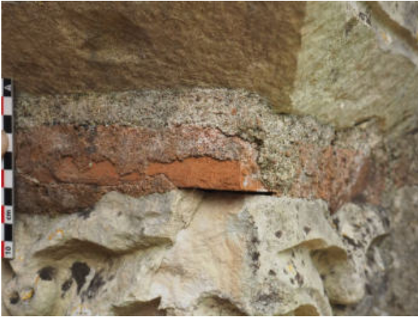
34. ↑ Brique couverte de mortiers entre tailloir et chapiteau de la 4 ème colonne : mortier de tuileau contemporain de la pose ou repose du tailloir, mortier de chaux et sable Cette intervention est antérieure à 1900 .P9124152
