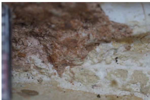
73. ↑ Grandeur nature, restes de badigeons couverts de restes de mortier de tuileau et de mortier de chaux P916477
