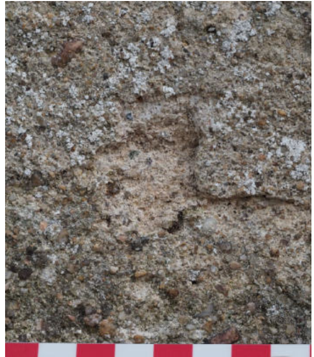
42. ↑ Détail grandeur nature de l'enduit à droite juste au-dessus du talus figure 41 : limite entre, en haut, une mince couche de mortier assez récent (des granulats du mortier sous-jacent dépassent à travers) et, en bas, un mortier plus ancien, au sable moins régulier et moins fin. Bien qu'il ressemble beaucoup au mortier de la restauration vers 1900, le mortier récent est postérieur à 1913 d'après les photos anciennes, il date probablement de 1962 P9154720
