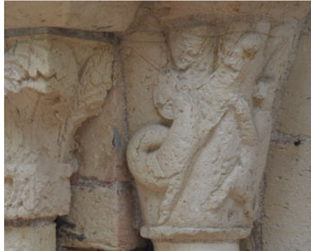
77. ↑ Le chapiteau central (copie de 1900, ici à gauche) et intérieur, (supposé d'origine, ici à droite) sont les plus touchés par l'exfoliation probablement liée à un plâtre de pose 1900 du chapiteau central P9164949 recadrée
