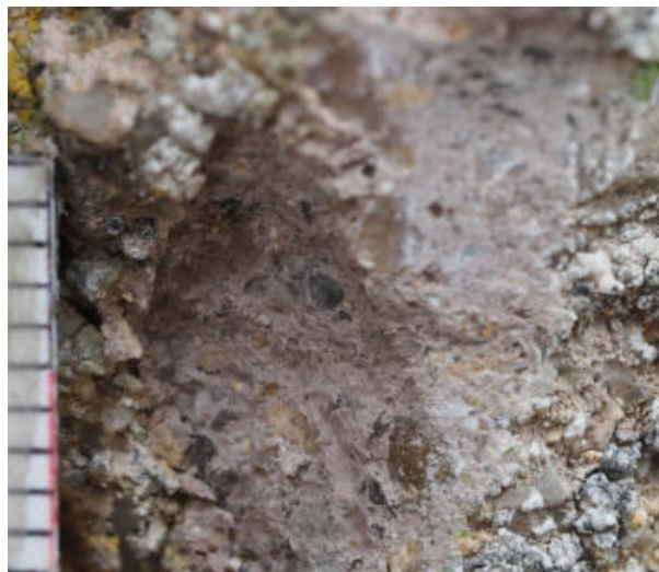
50. ↑ Détail grossi cinq fois environ. Le liant est moins dur que celui du ciment gris figure 48 P9134602
