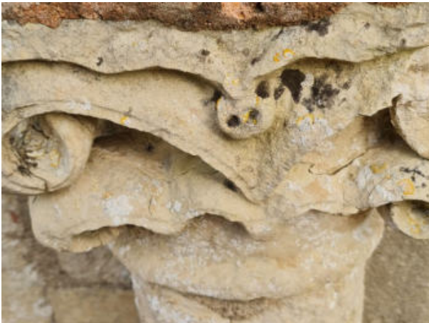
88. ↑ Détail des fissures multiples qui tendent à séparer les parties en saillie des parties plus massives du 4 ème chapiteau. 20220914_165301
