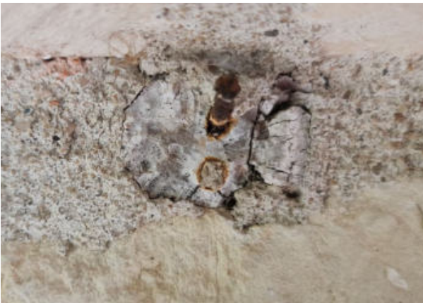
70. ↑ En retirant le bouchon de mortier on découvre des restes de d'un goujon de bois pourri (bouchon de mortier remis en place après photo). 20220915_100741
