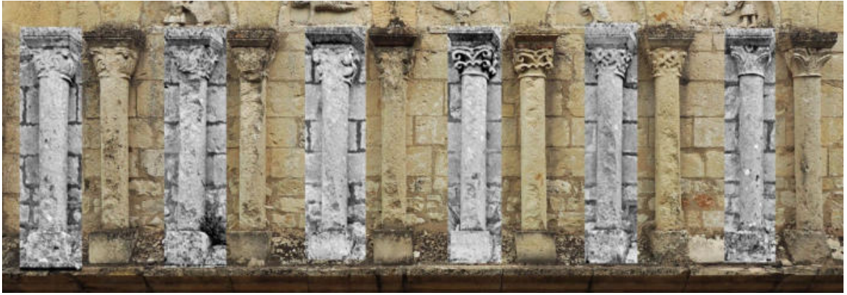
154. ↑ Photomontage des colonnes de la photo de Camille Enlart peu avant 1900, figure 109 page 33, sur un recadrage de la photo de la façade du 16/9/2022 figure 111 page 35 : contrairement au cas des reliefs, les pertes sur les colonnes sont pour l'essentiel anciennes. Ces pertes évoluent encore sous l'effet des sels (figure 101 page 28), mais moins vite qu'elles n'ont évolué sous l'effet des épisodes de gélifraction (par la conjonction d'épisode de gel intense peu après une période d'imbibition) auxquels elles se sont trouvées soumises il y a longtemps par l'élimination des arcades qu'elles portaient.
