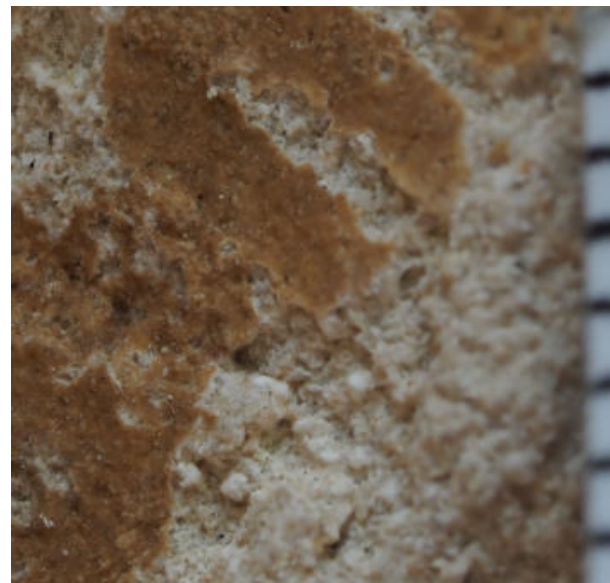
81. ↑ Détail en bas à droite figure 78, grossi dix fois environ : restes d'épiderme brunâtre et pierre abîmée par les sels. P9165024
