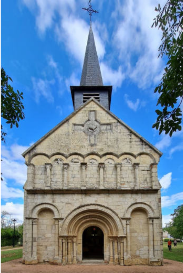
1. ↑ La façade lors de la visite pour devis. 20210910_163921 (photo redressée)
