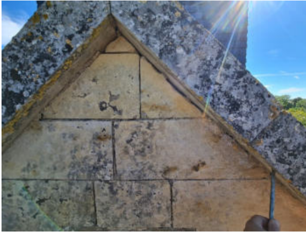
12. ↑ A droite sur la photo, prélèvement de pierre des dalles de couverture du pignon 20220912_111901
