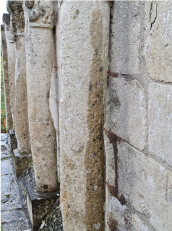
100. ↑ Pertes de matière très importantes derrière la 3 ème colonne, 2 ème à gauche sur cette photo. C'est probablement le gel qui explique ces pertes 20220915_114142
