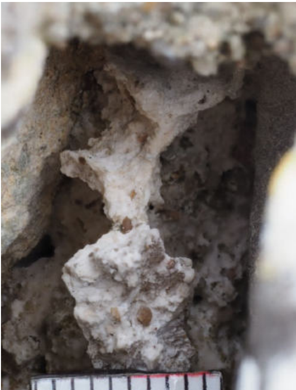
58. ↑ Détail grandeur nature. Au centre sur la photo une perte de mortier de sable et chaux laisse apparaître un matériau blanchâtre. La pierre à gauche est désagrégée et fissurée. P9144612
