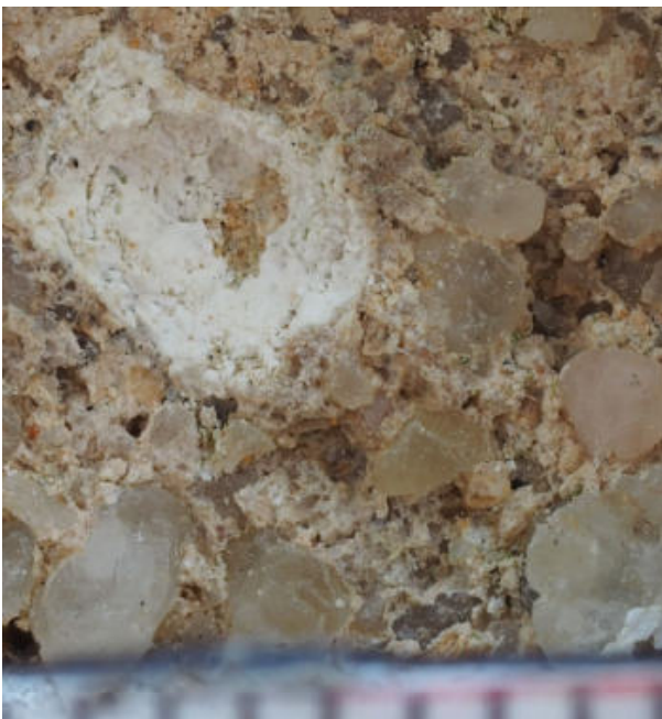
30. ↑ Détail grandeur nature du joint vertical au centre de la figure 29 : perte de rejointoiement découvrant le mortier de pose d'origine. P9164920
