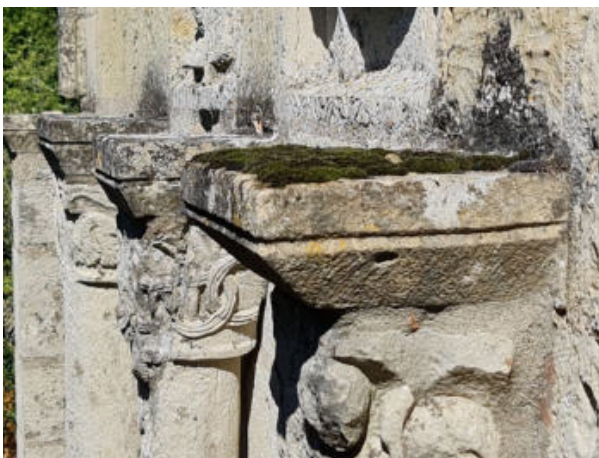
27. ↑ Tailloir du 3 ème chapiteau des colonnes hautes : profil différent (et pierre différente figure 23) 20220914_145945
