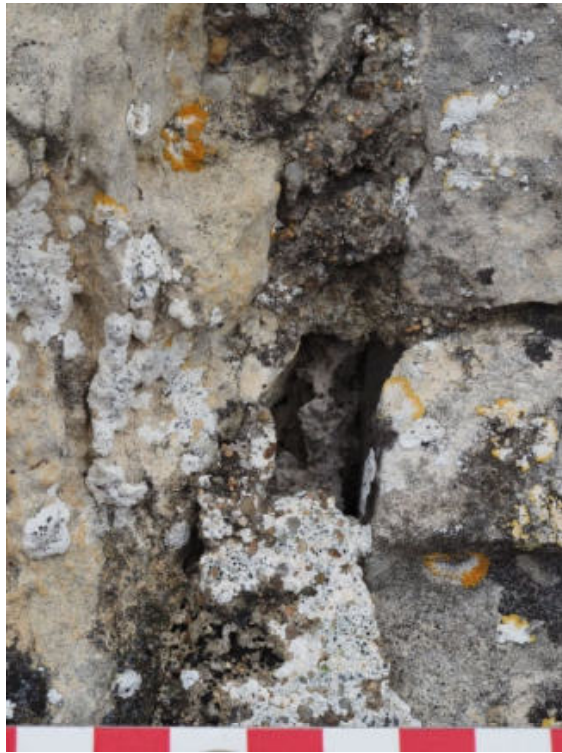
58. ↑ Détail grandeur nature. Au centre sur la photo une perte de mortier de sable et chaux laisse apparaître un matériau blanchâtre. La pierre à gauche est désagrégée et fissurée. P9144612
