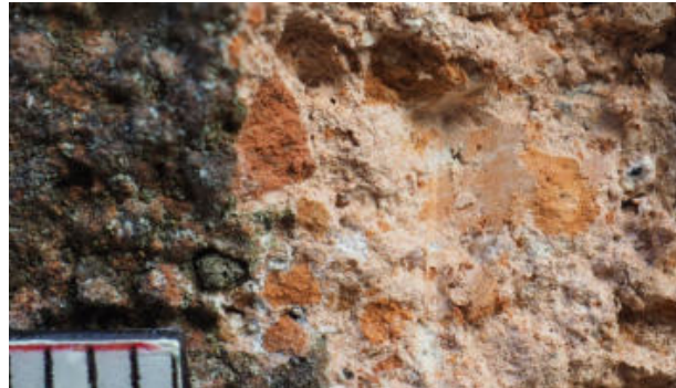
34. ↑ Brique couverte de mortiers entre tailloir et chapiteau de la 4 ème colonne : mortier de tuileau contemporain de la pose ou repose du tailloir, mortier de chaux et sable Cette intervention est antérieure à 1900 .P9124152
