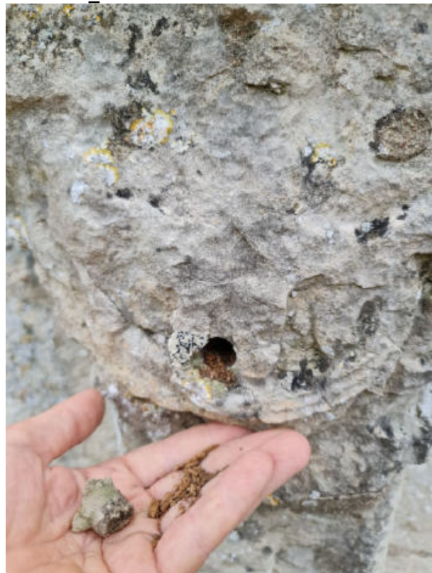
70. ↑ En retirant le bouchon de mortier on découvre des restes de d'un goujon de bois pourri (bouchon de mortier remis en place après photo). 20220915_100741
