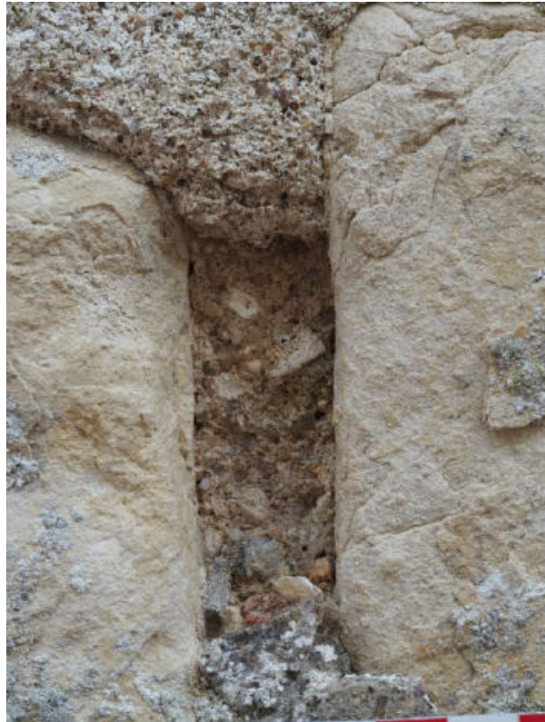
30. ↑ Détail grandeur nature du joint vertical au centre de la figure 29 : perte de rejointoiement découvrant le mortier de pose d'origine. P9164920
