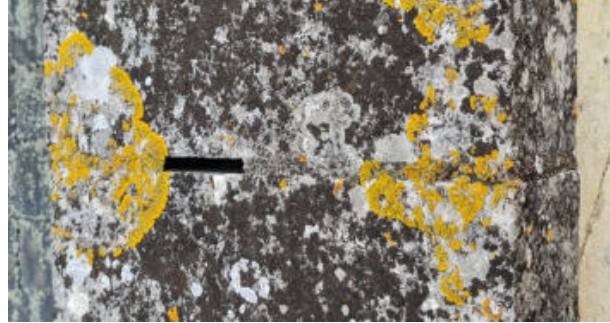
87. ↑ L'un des nombreux joints ouverts sur les rampants, ici en haut du rampant nord (ils sont encore plus nombreux au sud), ce trou coïncide avec la zone d'altération par les sels en haut à gauche de la croix (relevé figure 75 page 18, même type d'altération que figure 20 page 6) 20220913_160356
