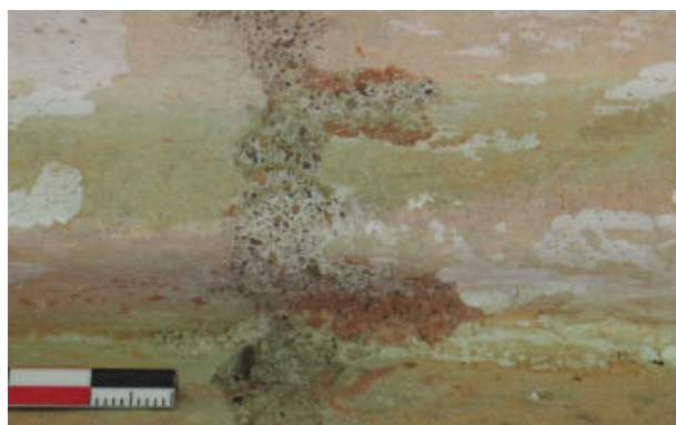
73. ↑ Grandeur nature, restes de badigeons couverts de restes de mortier de tuileau et de mortier de chaux P916477
