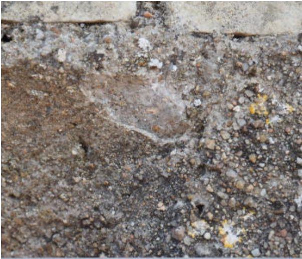
47. ↑ Jointoiment de sable et ciment en haut à droite de la branche verticale de la croix, grandeur nature : épiderme d'origine à gauche, cassure fraîche en haut au centre, érosion par la pluie avec dégagement des grains de sable plus résistants à droite. Ce mortier date de la restauration vers 1900 (figures 109 page 33, figure 110 page 34 ) P9124078
