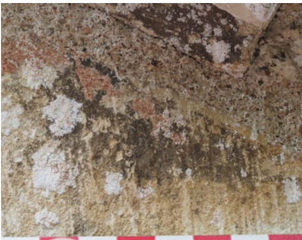
39. ↑ Restes de mortier de tuileau tout en haut à droite du portail P9164857
