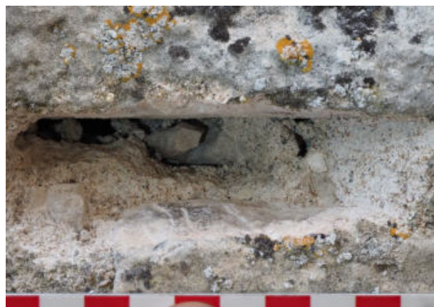
61. ↑ Sondage en bas à droite du 1 er relief : derrière le mortier de sable et chaux on distingue un plot de plâtre utilisé pour un blocage rapide P9134404
