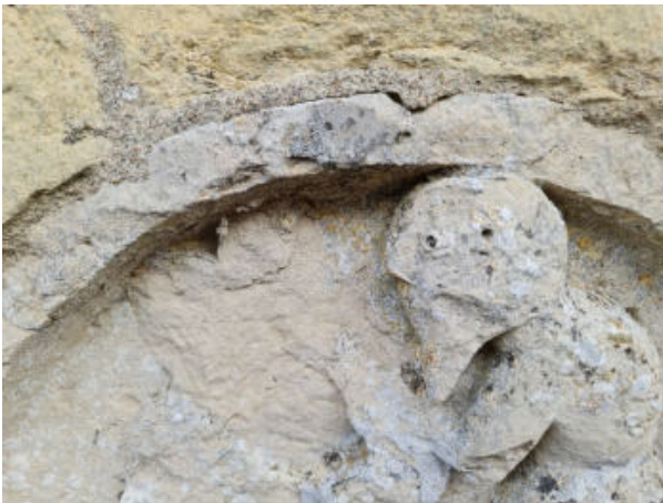
65. ↑ 5 ème relief, le même ciment blanc que figures 62 à 64 (vitreux et très dur) a été utilisé pour des collages et des coulis dans des fissures, détail ci-contre 20220914_171705
