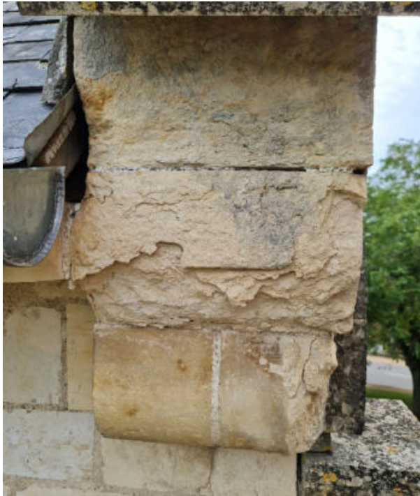
51. ↑ La console sous l'extrémité du rampant nord du pignon. L'eau entrant par le joint ouvert sur le rampant (figure 68 page 16) dissout le gypse du plâtre. Ce gypse cristallise dans pierre autour, souvent humidifiée mais jamais lixiviée, ce qui explique l'altération depuis le début du XXème siècle (figure 110 page 34) 20220913_134247
