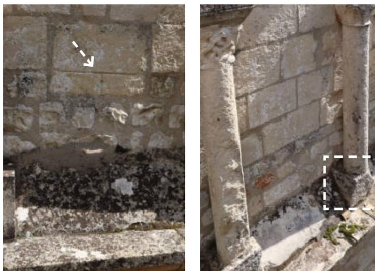
G. Tracé de faux-appareil sur une pierre alignée sur la maçonnerie en moellons H. Présence d'une unique base à angles chanfreinés, les autres sont de simples blocs
