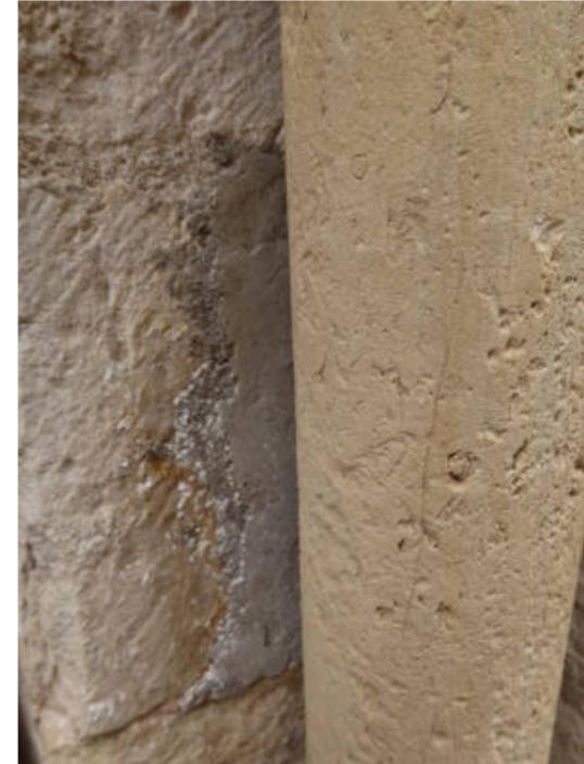
Ragréage au ciment derrière l'une des colonnettes d'un portail
