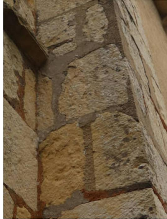
Reprise grossière au ciment ou au mortier de tuileau des jointoiments du contrefort Sud
