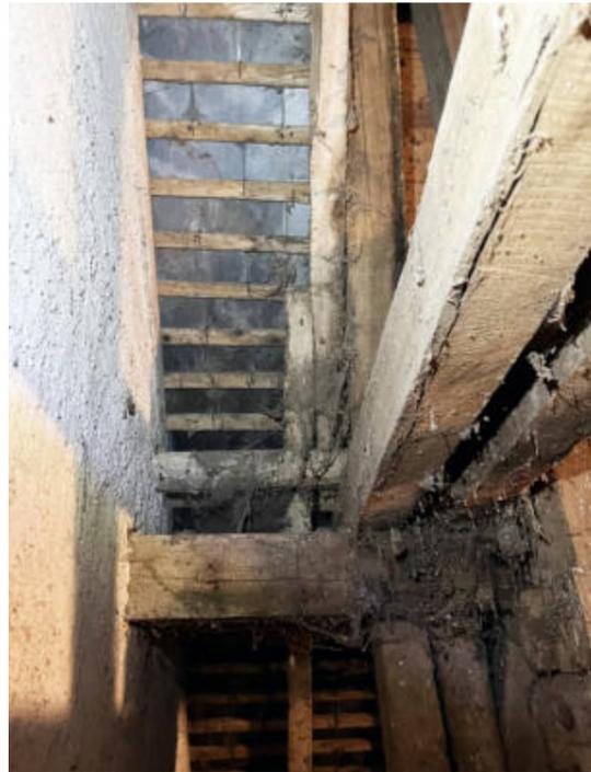
Bon état sanitaire des abouts de charpente empochés dans les maçonneries de la façade Ouest
