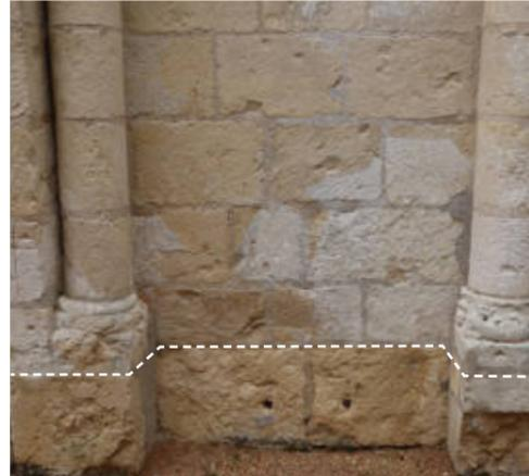
D. Niche droite – Grandes pierres de taille formant soubassement dans l'alignement des socles des colonnes et du portail
