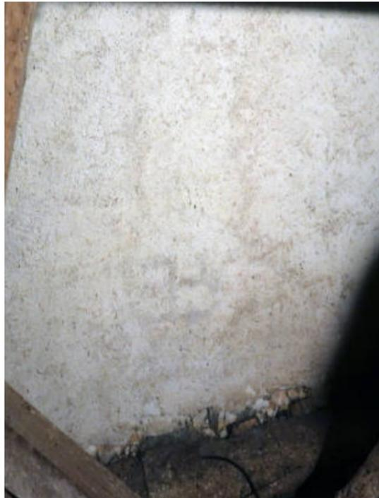
Bon état sanitaire de l'enduit très couvrant du pignon Ouest au niveau des combles du clocher
