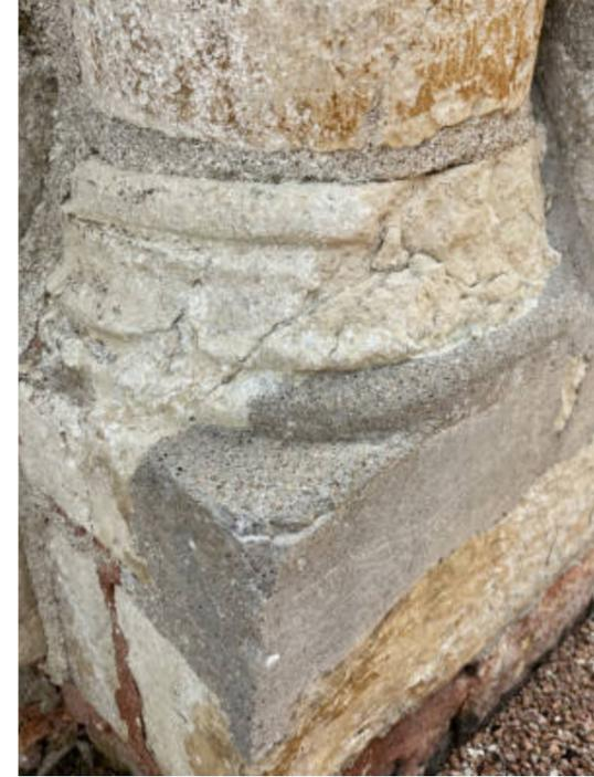
Ragréage d'un angle de la base et du socle d'une colonne de la niche latérale gauche
