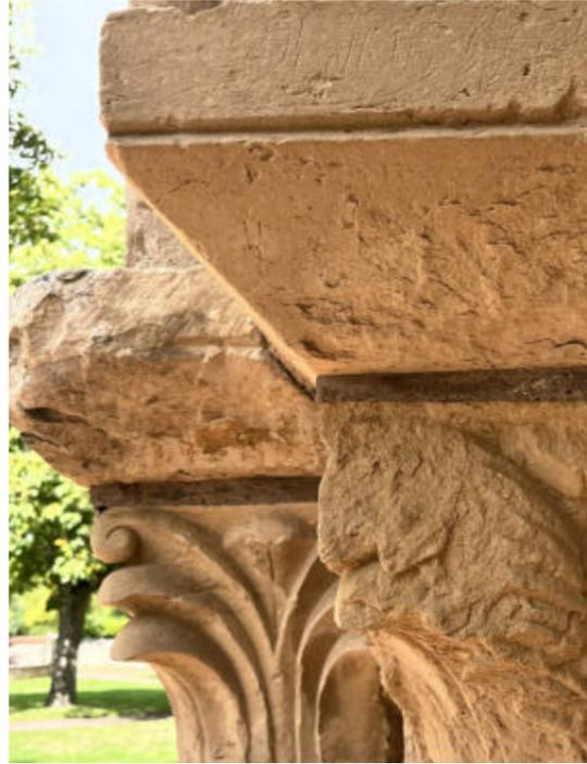
Jointoiment au ciment des tailloirs du côté gauche du portail
