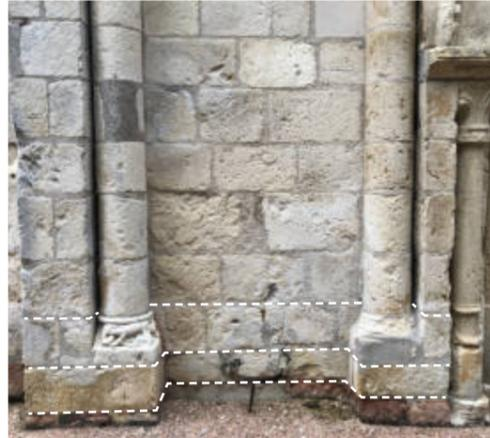
C. Niche gauche – Petit appareillage de pierre de taille en partie basse dans l'alignement des socles des colonnes et du portail
