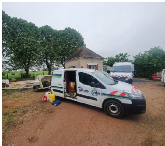
Les travaux ont été réalisés par la SAUR
