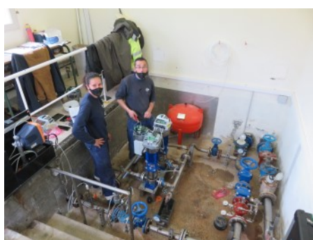
Les techniciens intervenant sur les deux surpresseurs
