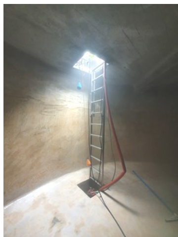
La cuve ou réserve d'eau a été nettoyée
