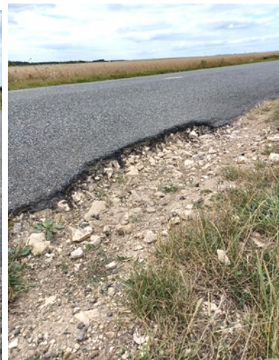
Dégradation de la chaussée vers Avord
