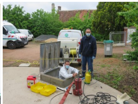
Les techniciens intervenant sur la réserve d'eau
