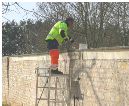
Étanchéité du dessus du mur du Clos St André
