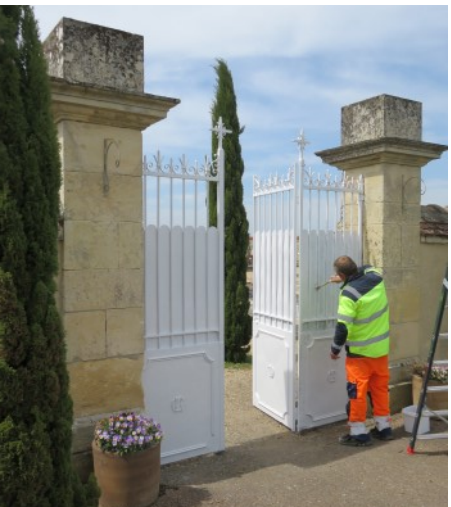
Décapage et mise en peinture du portail du cimetière
